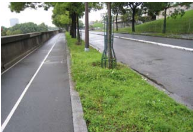
Trottoirs partiellement enherbés.
